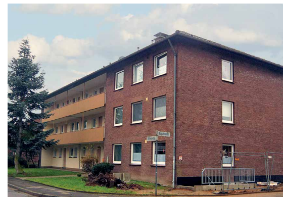
Abb. 1: So sahen die Gebäude vor der Modernisierung aus.
