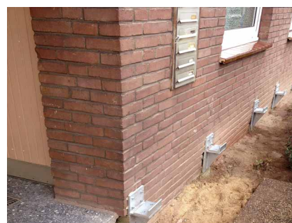
Abb. 5: Alles sicher: keine Feuchtigkeit im Mauerwerk
