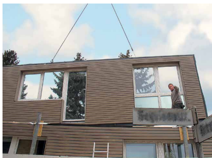
Abb. 2: Die Holzbauelemente wurden fix und fertig auf die Baustelle geliefert.
