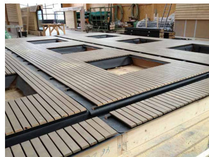
Abb. 4: Die Bearbeitung geschieht wetterunabhängig, daher kann man die Vorfertigung präzise planen und die Bauabschnitte genau einhalten.
